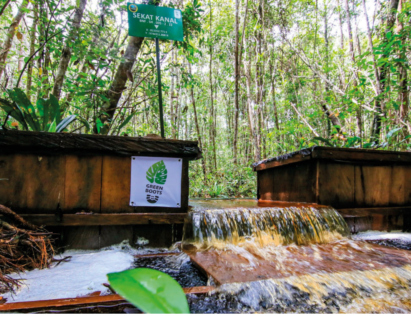
Zuvor kartierte Kanäle werden mit Dämmen verbaut, damit das Wasser nicht aus dem Wald fließen kann. Dazu ist auch ein Überlauf nötig, da sich das Wasser sonst bei viel Regen seitlich der Dämme einen Weg suchen und die Dammkonstruktion erodieren würde. Foto: Borneo Nature Foundation
