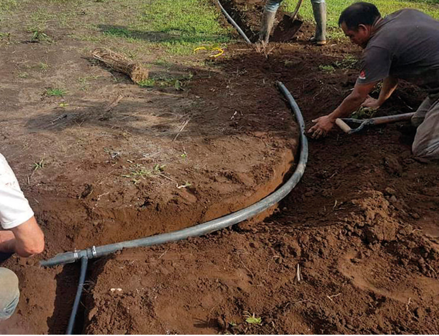
Hier werden die Wasserleitungen für die Haushaltanschlüsse verlegt – natürlich alles von Hand. Foto: AMAZONICA
