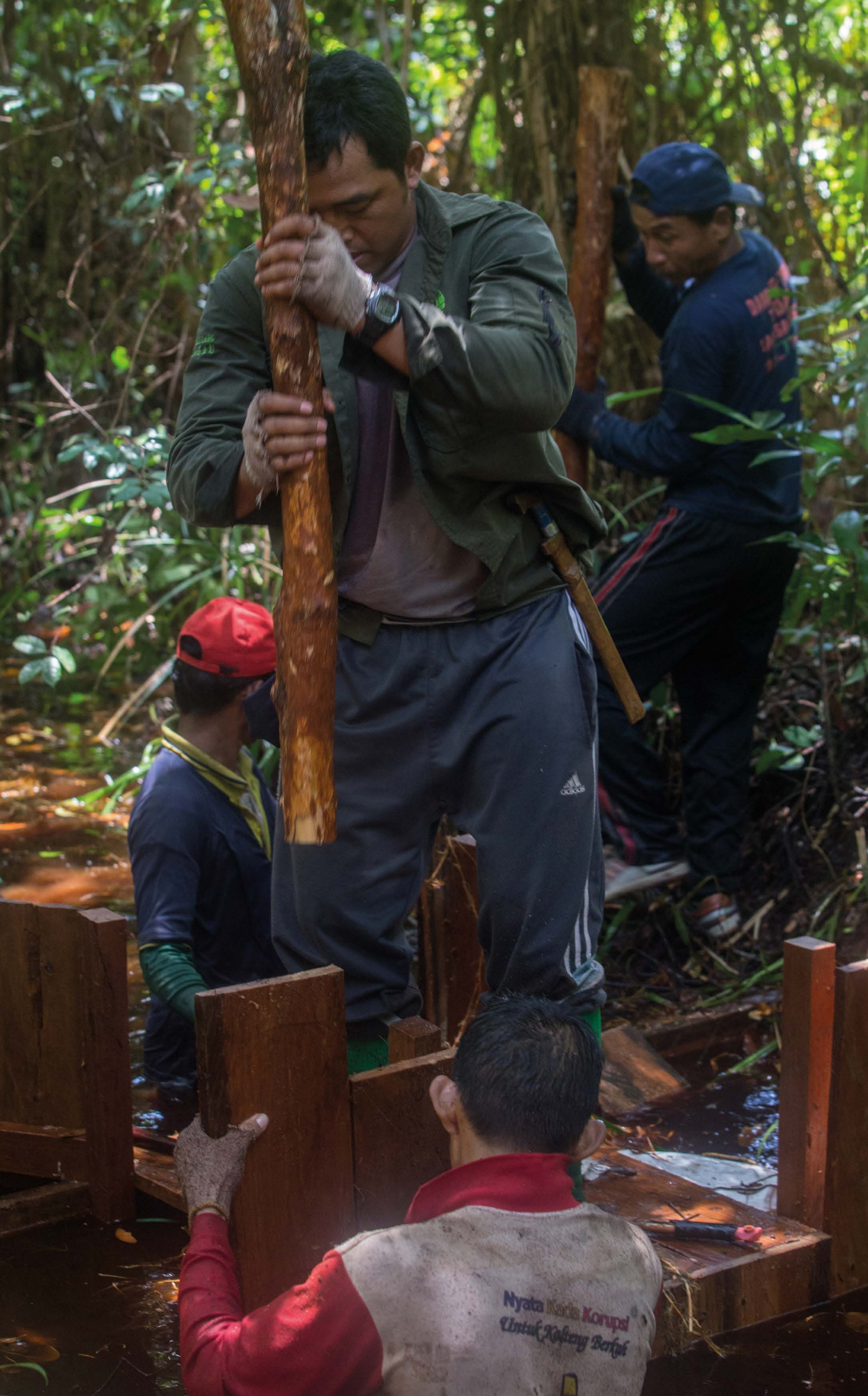
Hier werden die illegalen Kanäle wieder geschlossen. Dazu ist ein Überlauf für die Langlebigkeit der Dämme notwendig. Denn ohne Überlauf würde das Wasser bei sehr vollen Kanälen an den Seiten überlaufen und eine Erosion des Torfs neben den Dämmen verursachen. Messungen haben gezeigt, dass der Wasserabfluss mit dem Bau der Dämme bis zu 80% reduziert werden konnte. Foto: Borneo Nature Foundation
